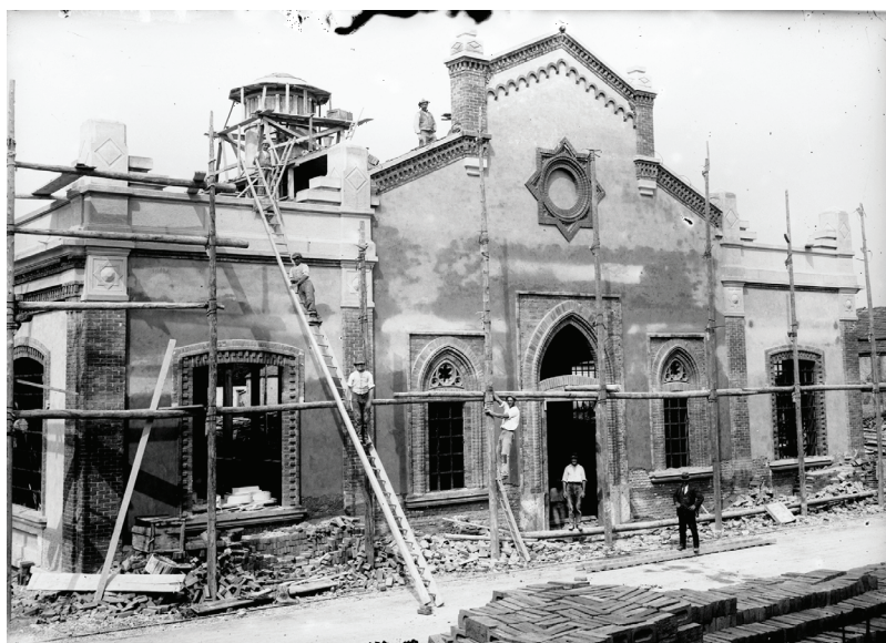
Lavori per la costruzione dell'edificio del reparto tintoria (1923)
