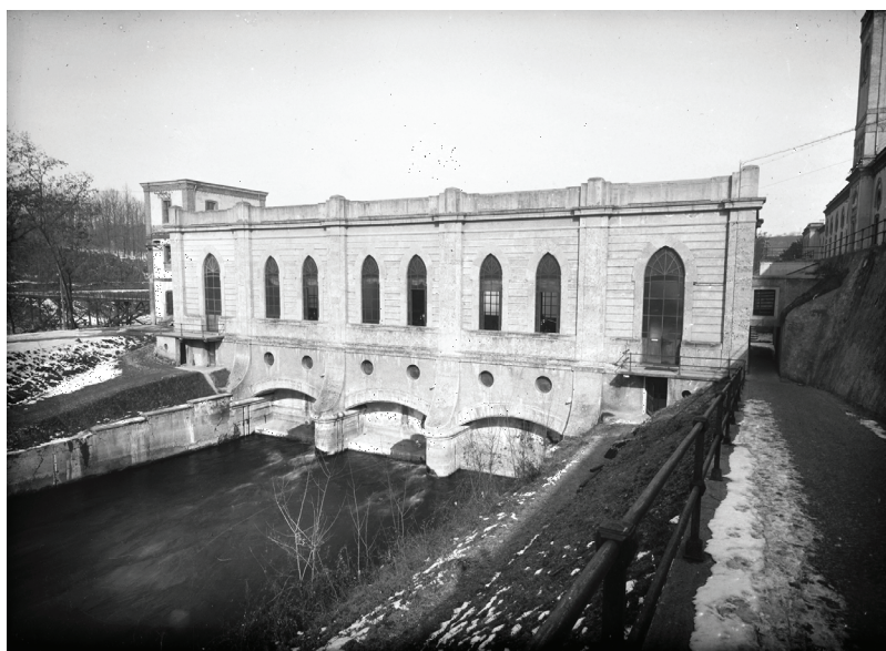
Veduta della diga di sbarramento sul fiume Adda con centrale idroelettrica per l'approvvigionamento di energia del cotonificio di Crespi d'Adda (primo quarto XX sec.)
